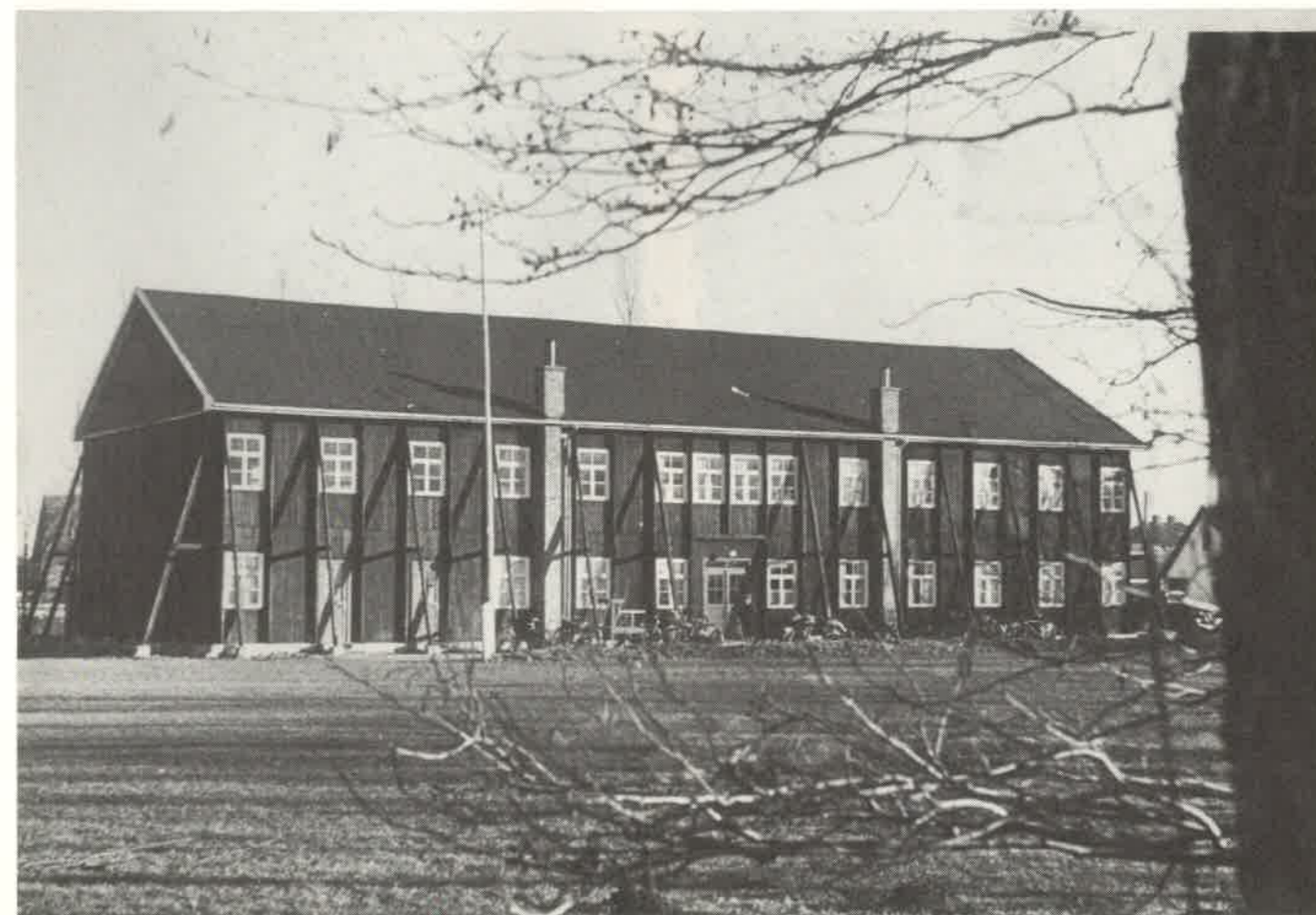
Den færdigbyggede hal set fra jernbanen.
