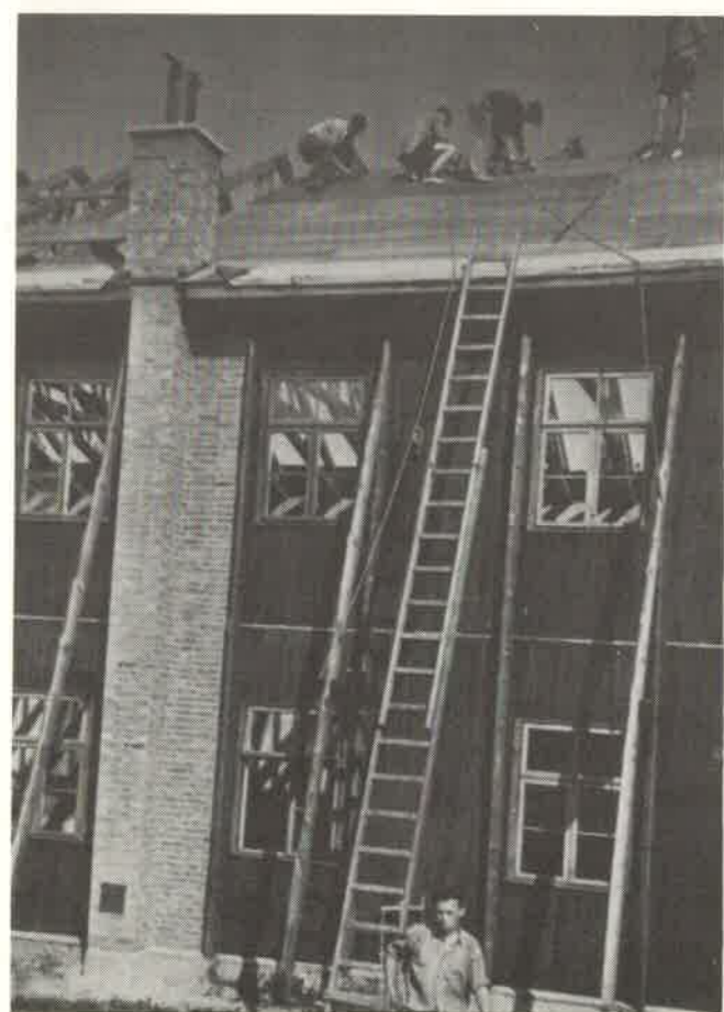
Glimt fra byggeriet af hallen.
